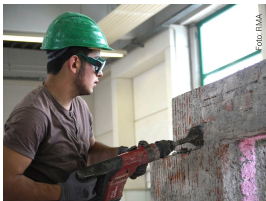
In der BAUAKademie wurde der Aufwand für den Rückbau an verschiedenen Bauteilen unter realitätsnahen Umständen gemessen.
