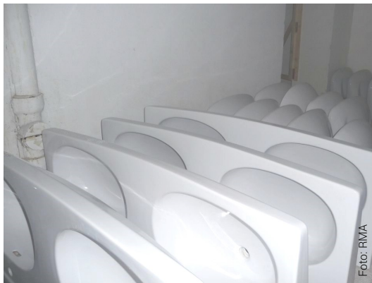
Waschbecken, Türen, Beschläge, Beleuchtungskörper, Heizkörper, Fliesen und viele Möbel wurden aufbereitet und im Hotel wieder eingebaut.
